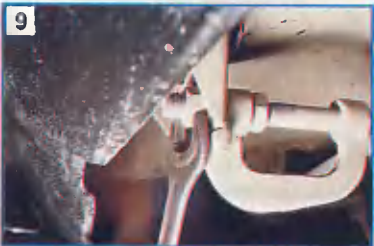
Ключом "на 24" отворачиваем гайку тяги поперечины передней подвески.
