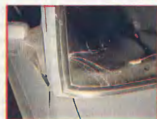
Из-за ерундовой трещины стражи безопасности принудили к замене стекла.
